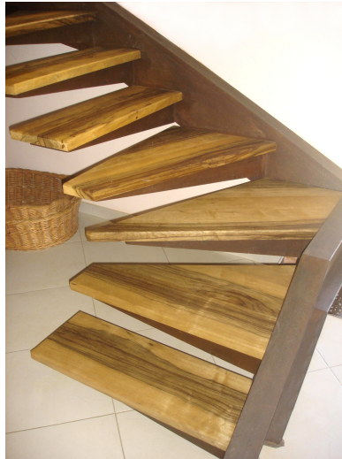
Escalier suspendu demi-tournant (Fraké bariolé) - Saint-Gély-du-Fesc (France)
